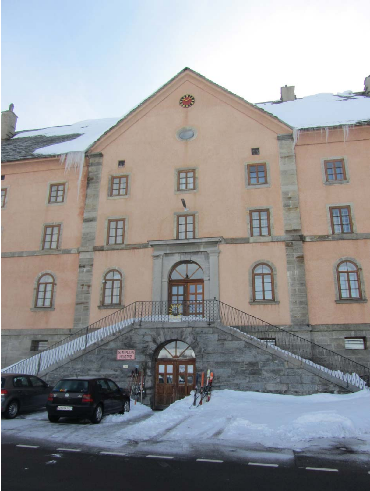
Hospice gravé à jamais dans nos cœurs qui sait accueillir le voyageur égaré comme celui de passage. On peut se changer dans les sous-sols en vue d'expéditions fabuleuses.
